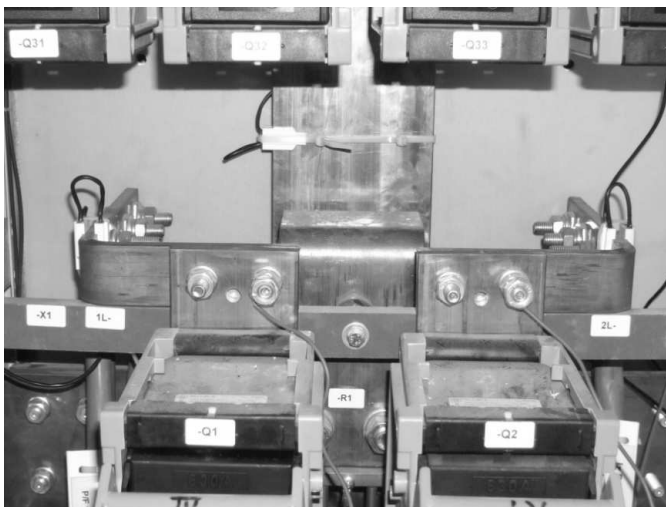
Слика 3. Сензори за мерење струје базирани на Холовом ефекту
